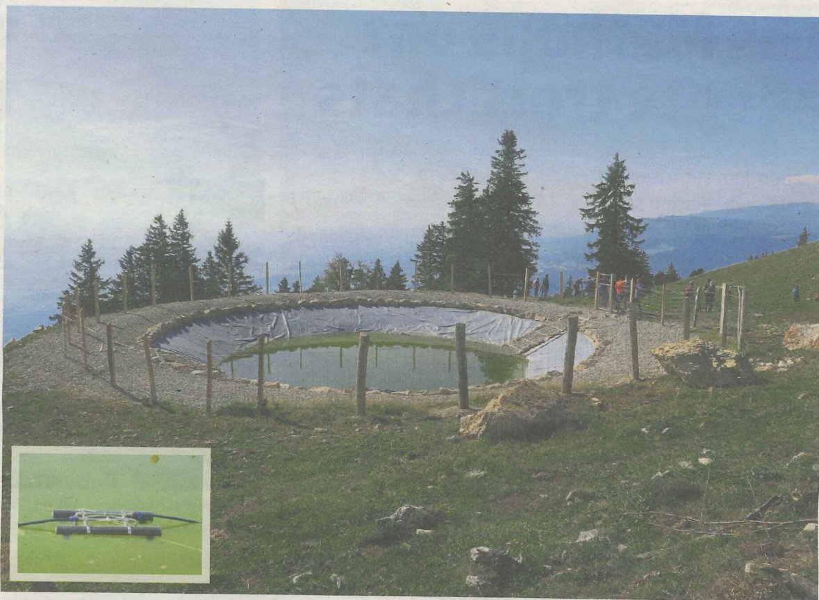
Le bassin de 250 m 3 a permis de doubler la capacité de stockage de l'alpage du Suchet. Un petit radeau permet de prendre l'eau à 15 cm sous la surface. Elle est distribuée par gravité dans les bassins situés au nord et à l'est du pâturage. PHOTOS RAPOSO
